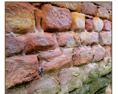
Mur en moellons de grès dégradé par l'humidité et les attaques bactériennes.
